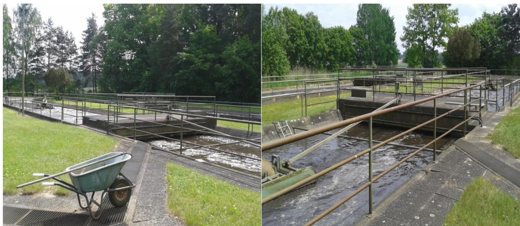
**Abbildung 3-3: Mammutrotoren der Kläranlage Bienenbüttel auf den Umlaufgräben**
