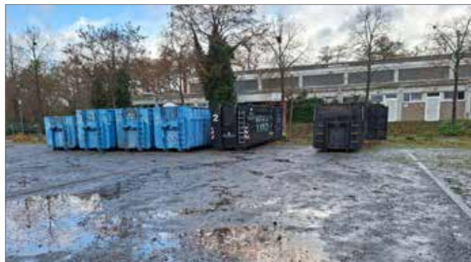
Die Container sind angerollt und füllen sich im Zuge der Entkernung der Halle schnell mit den alten Baustoffen. Fotos: Gemeinde Bienenbüttel.
