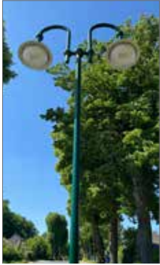
Im Zuge der Energiekosteneinsparung bleibt die Straßenbeleuchtung im Frühjahr und Sommer abgeschaltet. Foto: privat
